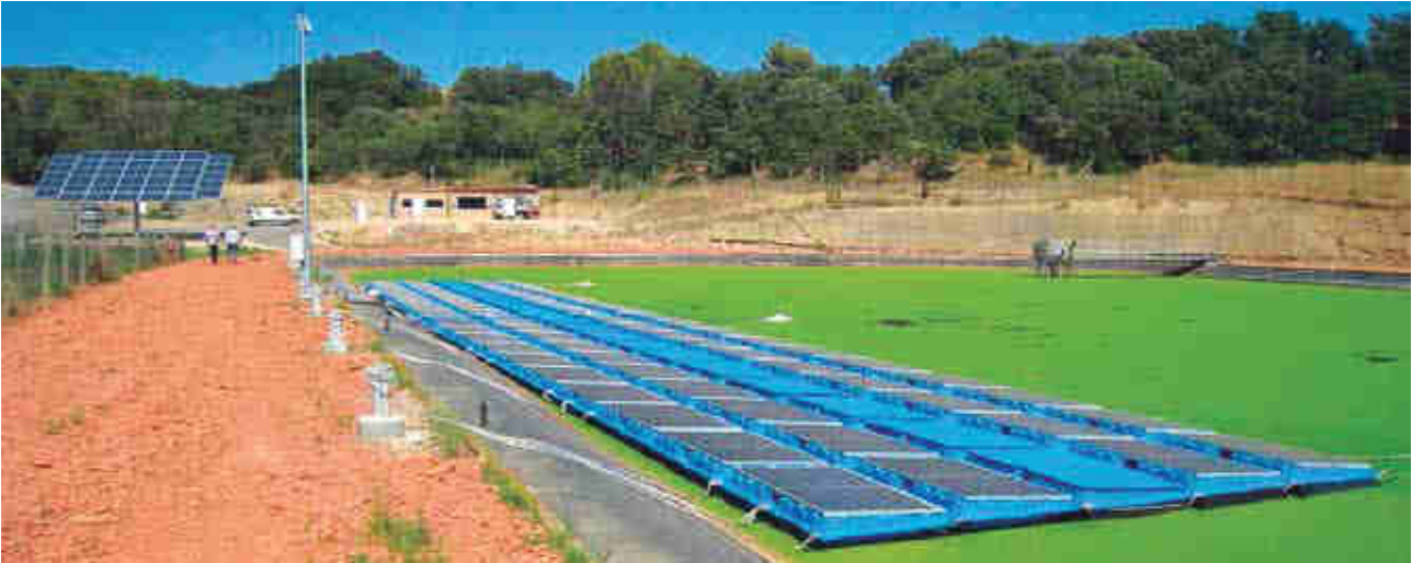
FIGURA 3 Sistema fotovoltaico flotante instalado en balsa depuradora para la bodega Viñas del Vero, como parte del proyecto europeo Life Rewind . Más información en: https://www.intergia.es/life-rewind/
