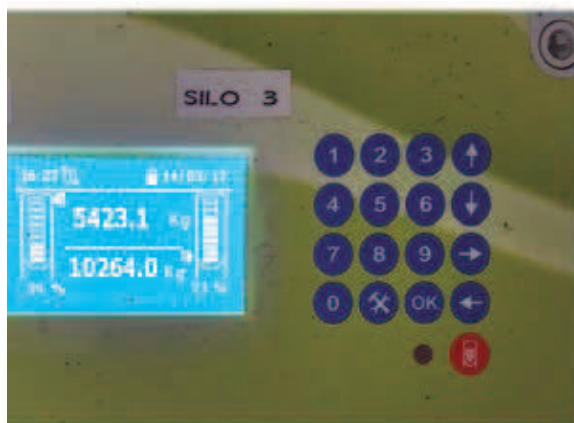
Imágen 2: Control digital de la cantidad de pienso en los silos.
