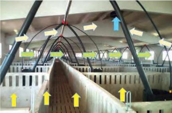
Efecto (viento, chimenea, apertura) de ventilación en una nave con ventilación natural. (con lo que es necesario tener programas las temperaturas de apertura de chimeneas y ambos lados de las ventanas, para alcanzar el confort térmico).
