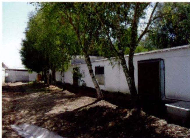
Placas de refrigeración
