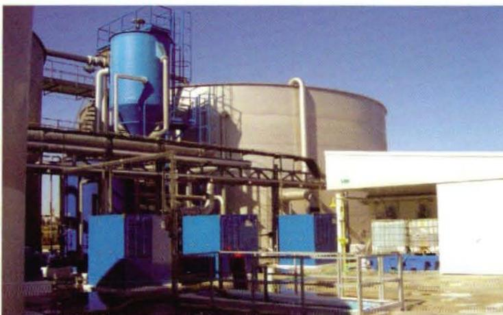
Figura 28.- Reactor biológico del centro de tratamiento de aguas residuales en el que se obtiene una fracción líquida clarificada.
