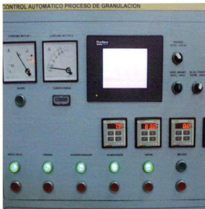
Figura 10.- Panel de control del proceso de granulación.
